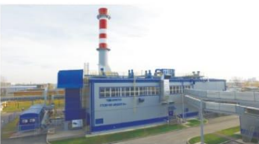
Строительство ГТЭУ-16 «Волга» – завершающий этап реализации комплексной программы по повышению энергоэффективности предприятия.
