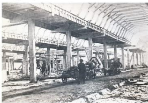
Строительство главного корпуса. 1938 г.
